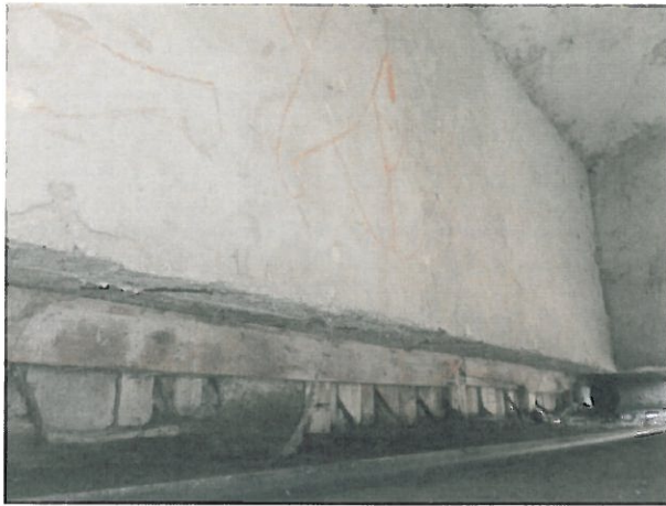
Foto 20 – Cofraj în Rost de dilatație
