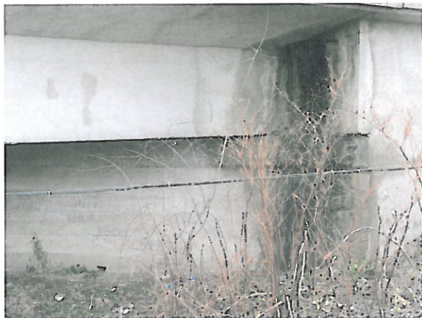
Fotografia 12 – Infiltrații.
