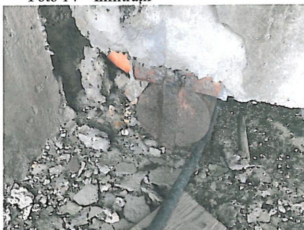
Foto 16 – Aparat de reazem mobil
