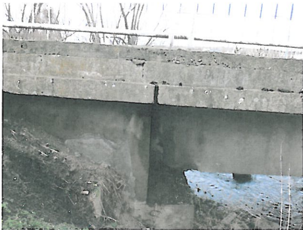
Foto 4 – Banchete de rezervare mal stang amonte
