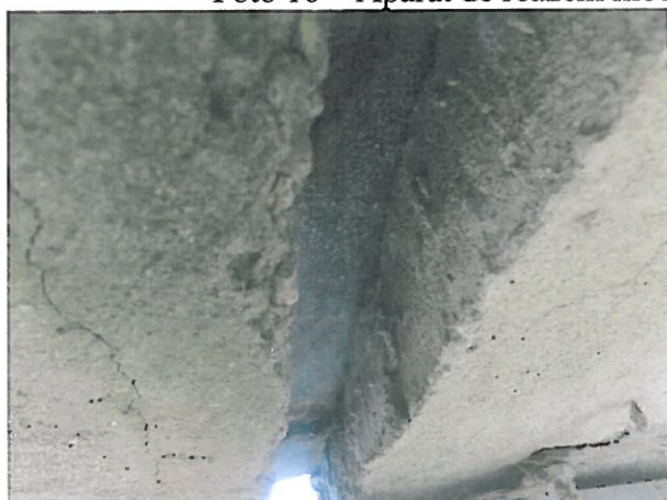
Foto 18 – Rost de dilatație
